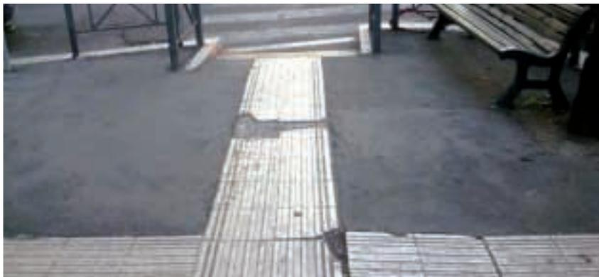
In alto: stato di degrado di un percorso per non vedenti
